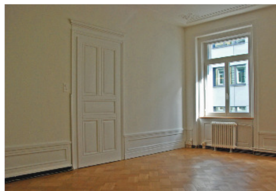
Blinde Tür. Schweizergasse 21, 8001 Zürich
